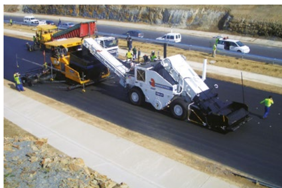
Два асфальтоукладчика работают параллельно. Один получает смесь от перегружателя Shuttle Buggy.
