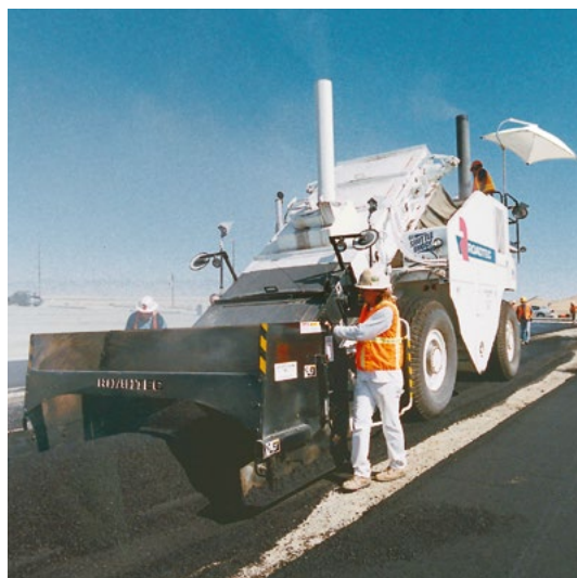
Устройство для подбора материала из валика.
