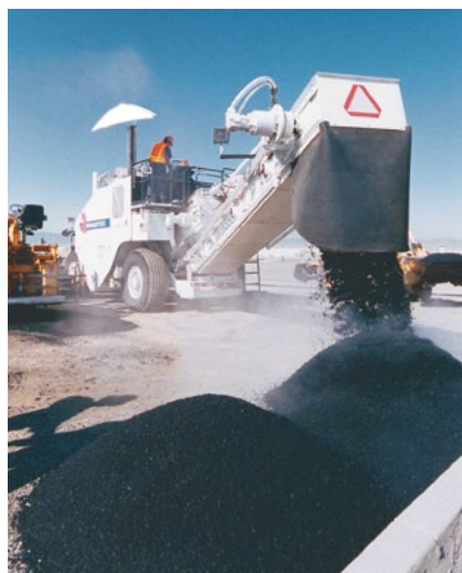
Перегрузатель Roadtec может доставить смесь точно туда, где она необходима рабочим.
