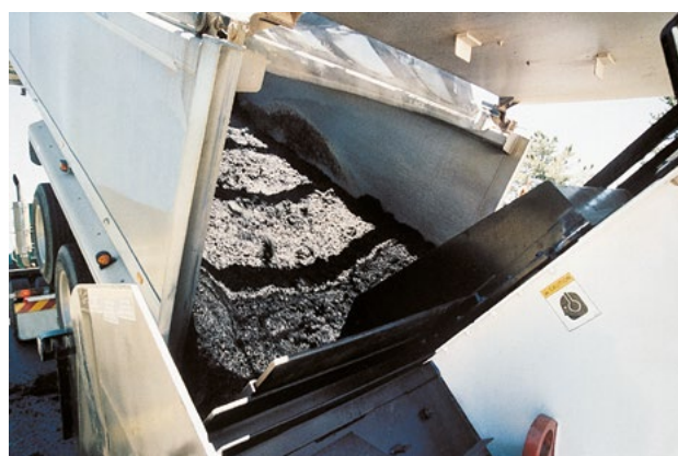
Даже из такой смеси можно получить высококачественное покрытие, если пропустить ее через перегружатель Roadtec.
