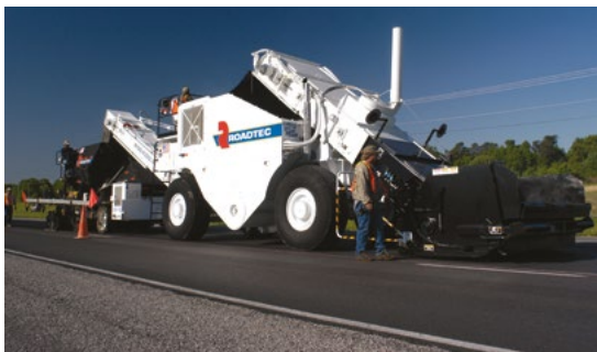
Перегружатель Shuttle Buggy снабжает асфальтоукладчик смесью и обеспечивает безостановочное движение.
